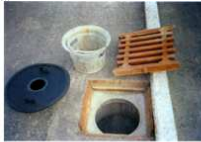
Deckel und Schmutzfänger entfernen
