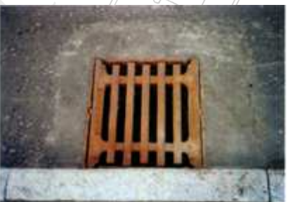
Deckel des Regeneinlaufes schließen - fertig.
