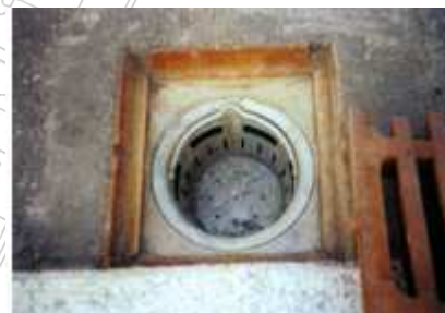
Schmutzfänger eingesetzt
