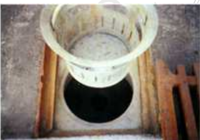
Schmutzfänger wieder einsetzen
