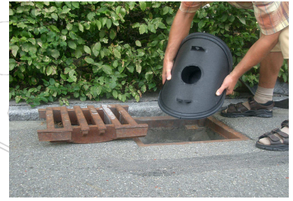
Flexiblen Kunststoffeinsatz leicht durchbiegen
